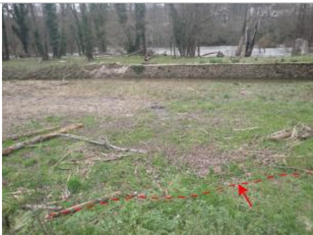
Vue de la laisse d'inondation - Auteur : AGERIN
