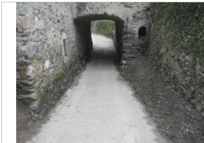
Vue du site - Auteur : AGERIN
