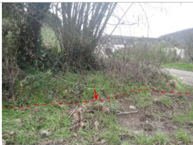
Vue de la laisse d'inondation - Auteur : AGERIN
