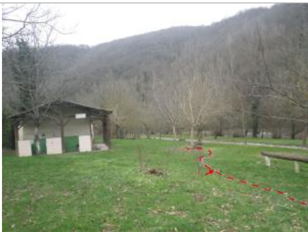
Vue de la laisse d'inondation - Auteur : AGERIN
