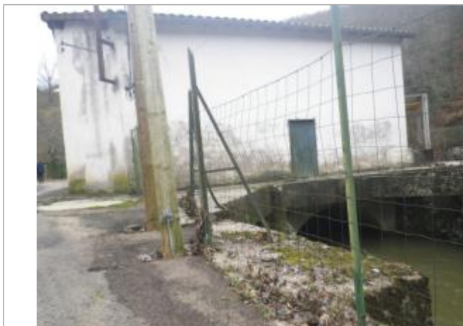
Vue du site - Auteur : AGERIN
