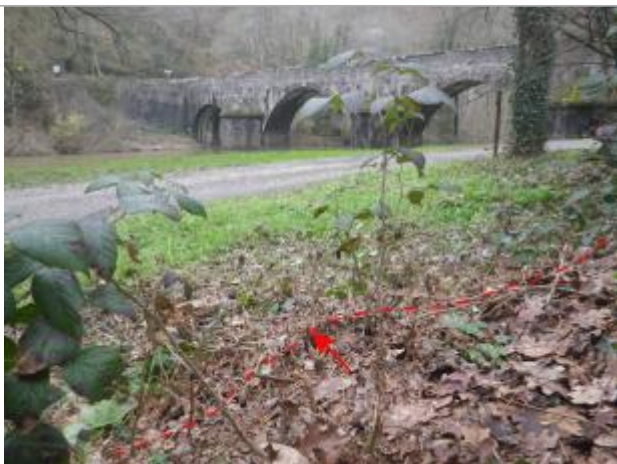
Vue de la laisse d'inondation - Auteur : AGERIN
