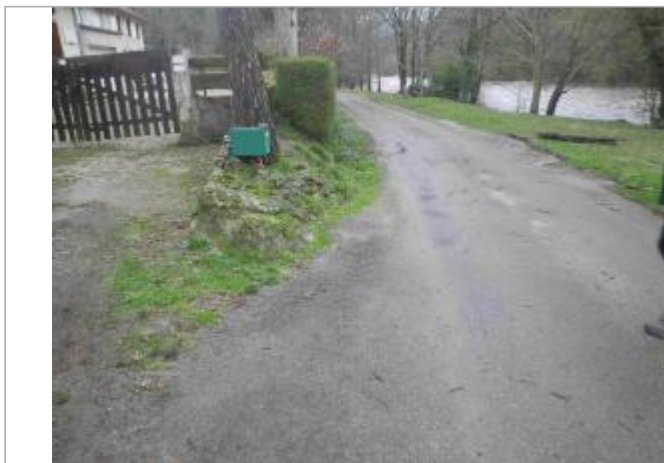
Vue du site - Auteur : AGERIN
