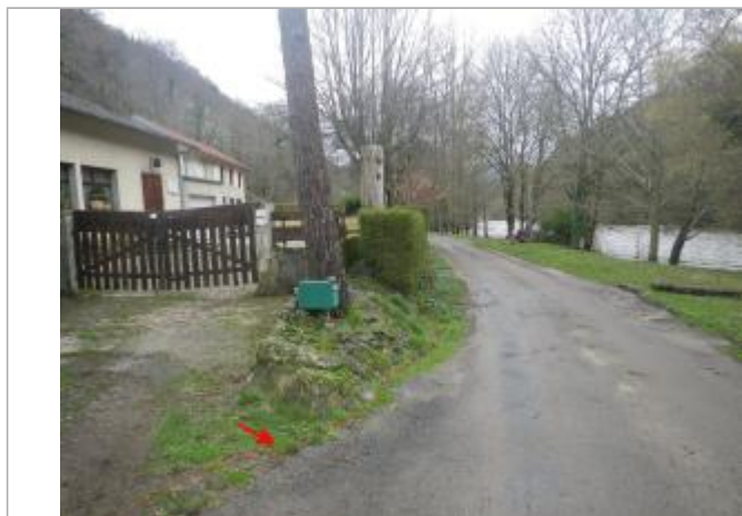
Vue de la laisse d'inondation - Auteur : AGERIN
