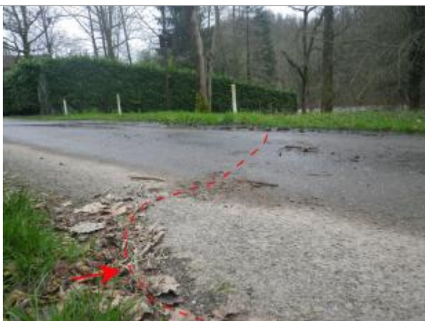
Vue de la laisse d'inondation - Auteur : AGERIN
