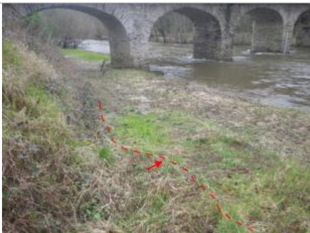
Vue de la laisse d'inondation - Auteur : AGERIN
