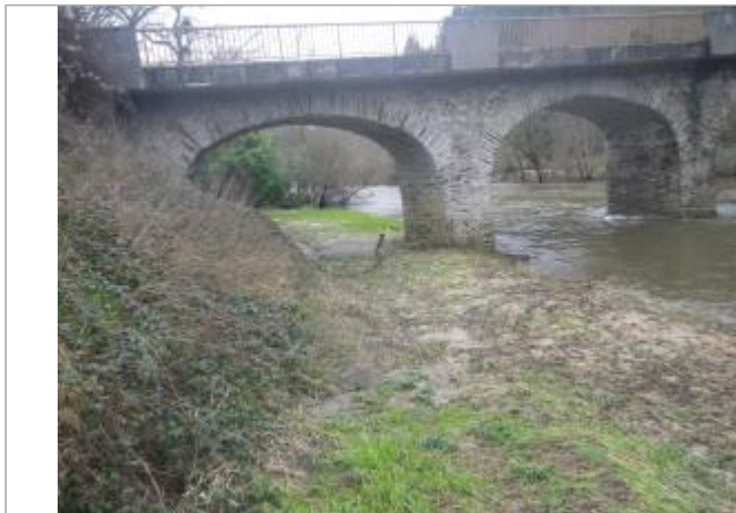
Vue du site - Auteur : AGERIN
