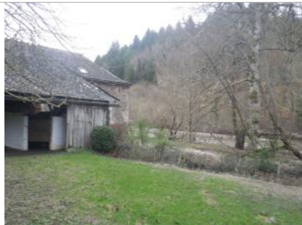
Vue du site - Auteur : AGERIN
