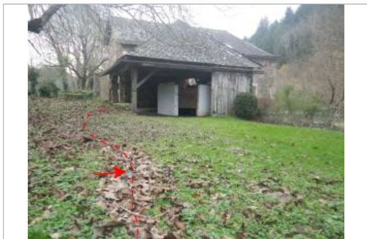
Vue de la laisse d'inondation - Auteur : AGERIN
