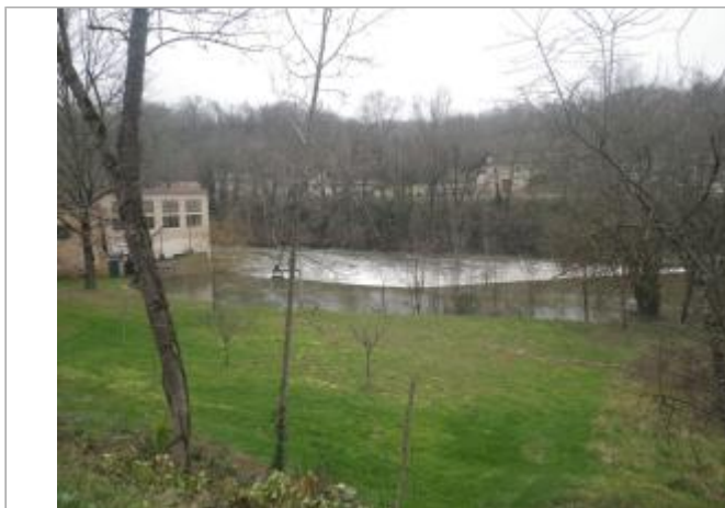
Vue du site - Auteur : AGERIN
