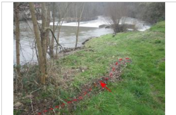
Vue de la laisse d'inondation - Auteur : AGERIN
