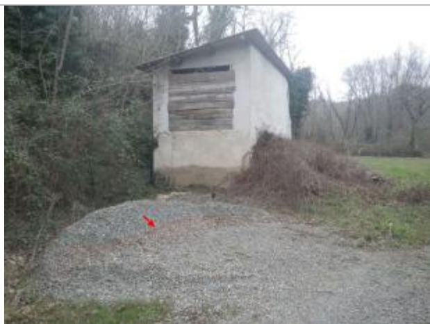
Vue de la laisse d'inondation - Auteur : AGERIN
