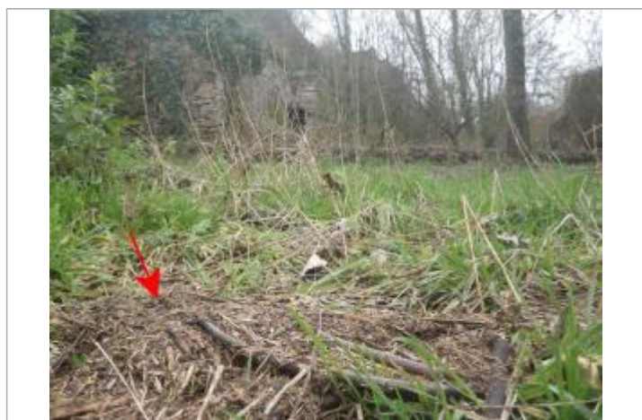
Vue de la laisse d'inondation - Auteur : AGERIN
