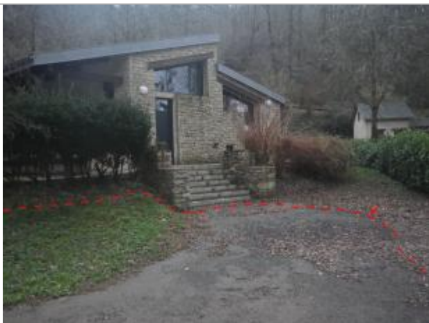
Vue de la laisse d'inondation - Auteur : AGERIN
