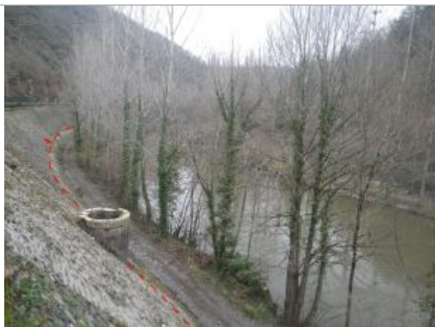
Vue de la laisse d'inondation - Auteur : AGERIN
