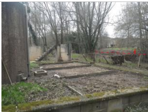
Vue de la laisse d'inondation - Auteur : AGERIN
