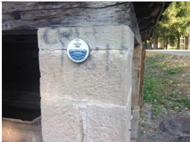
MONT-1 : L'Assou au niveau du lavoir de Monteils - crue du 14 décembre 1981
