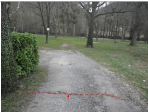
Vue de la laisse d'inondation - Auteur : AGERIN
