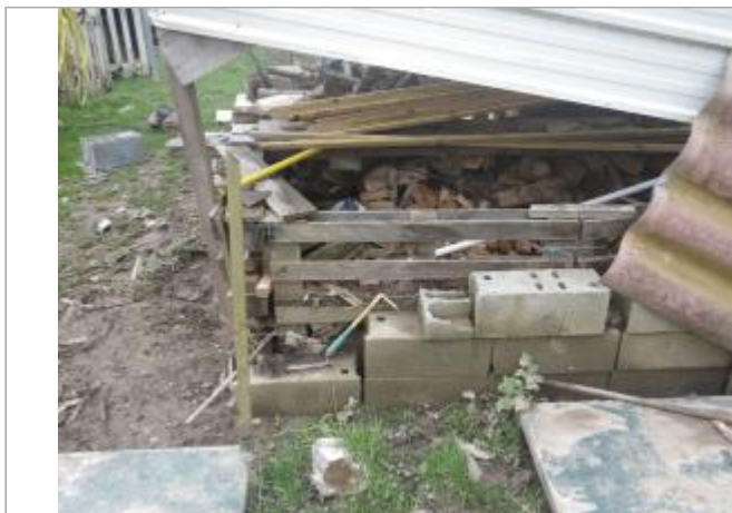
Vue du site - Auteur : AGERIN
