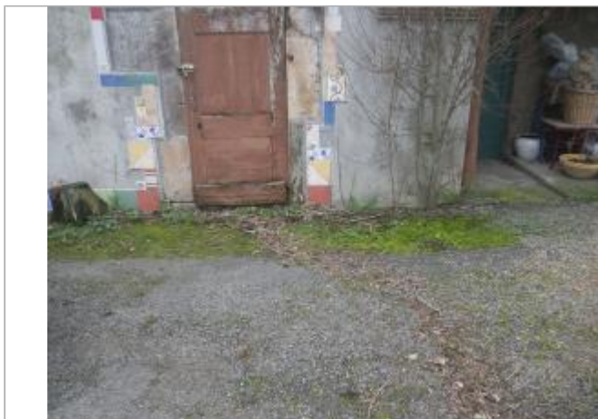
Vue du site - Auteur : AGERIN
