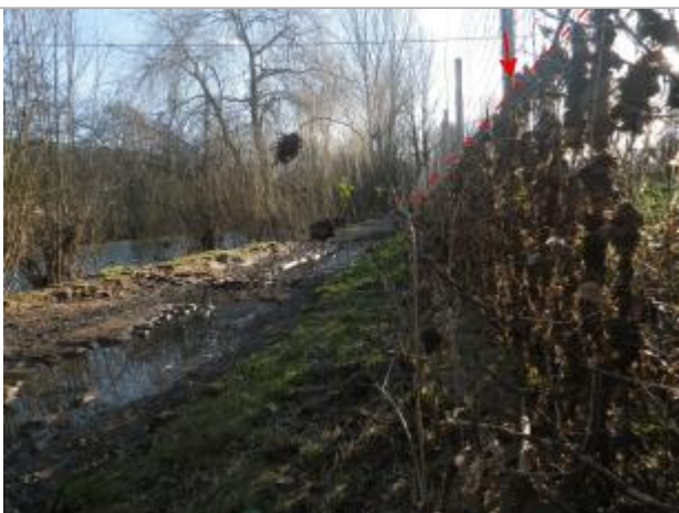
Vue de la laisse d'inondation - Auteur : AGERIN
