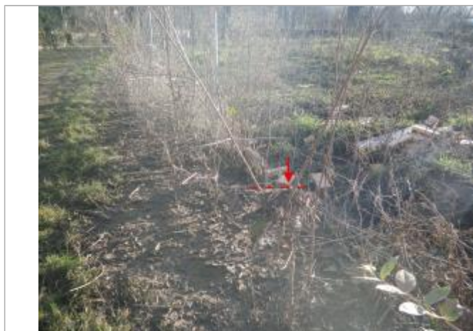
Vue de la laisse d'inondation - Auteur : AGERIN
