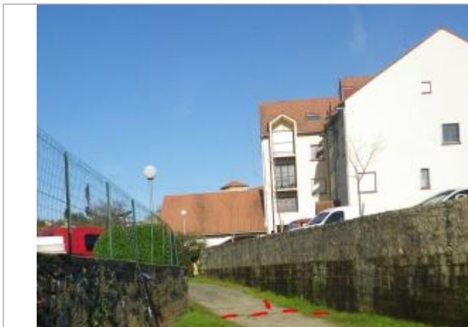
Vue de la laisse d'inondation - Auteur : AGERIN
