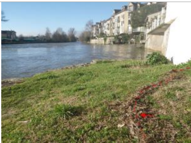
Vue de la laisse d'inondation - Auteur : AGERIN
