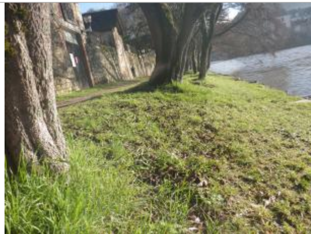
Vue du site - Auteur : AGERIN
