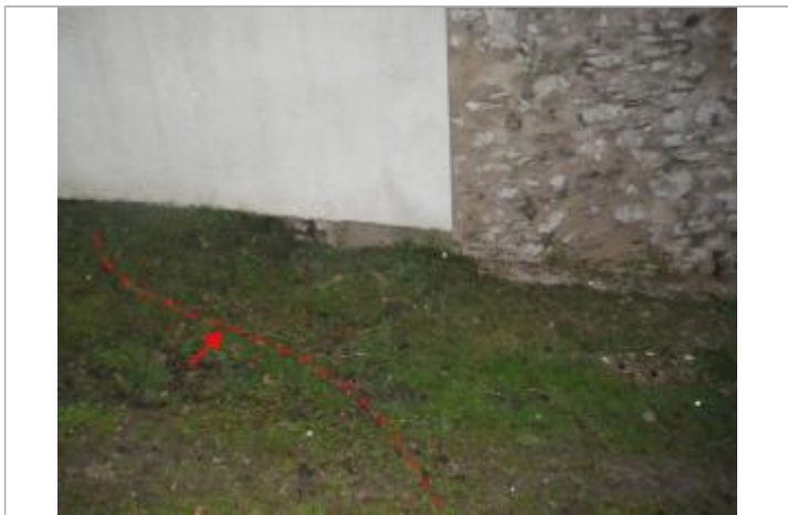
Vue de la laisse d'inondation - Auteur : AGERIN
