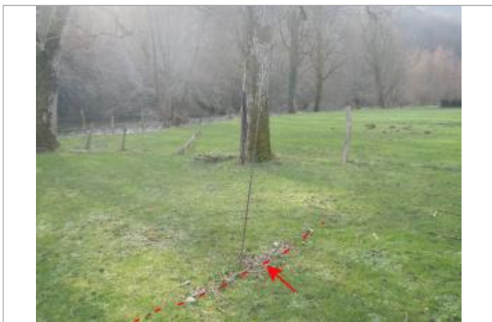
Vue de la laisse d'inondation - Auteur : AGERIN
