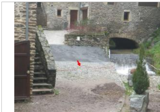
Vue de la laisse d'inondation - Auteur : AGERIN
