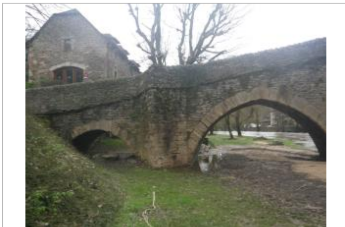
Vue du site - Auteur : AGERIN
