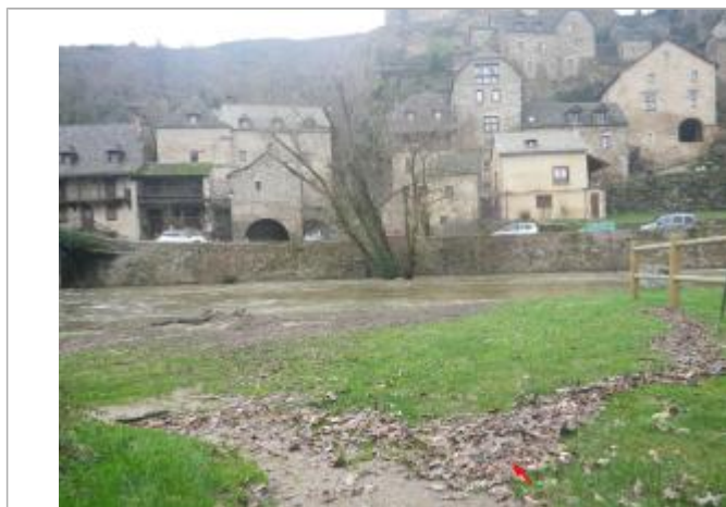
Vue de la laisse d'inondation - Auteur : AGERIN
