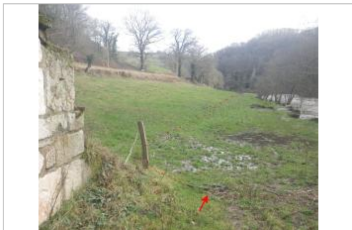
Vue de la laisse d'inondation - Auteur : AGERIN
