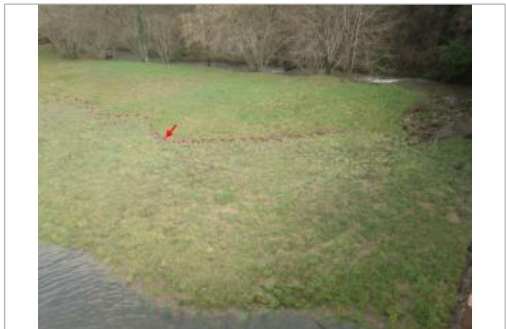
Vue de la laisse d'inondation - Auteur : AGERIN
