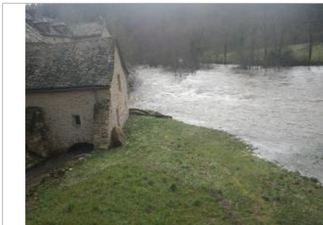
Vue du site - Auteur : AGERIN
