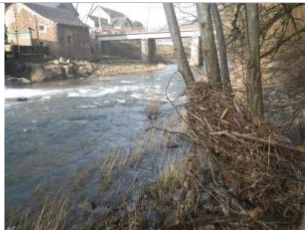
Vue du site - Auteur : AGERIN
