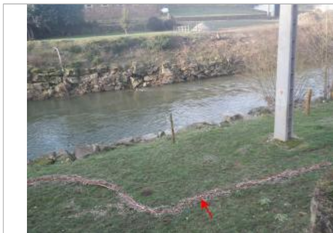
Vue de la laisse d'inondation - Auteur : AGERIN
