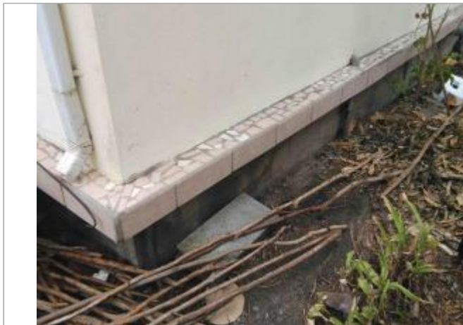
Vue du site : Maison Grande Anse - Auteurs: DEAL, UAG
