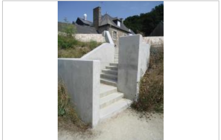
Escalier barrage de la Grande Chaussée - Source : SMAP, 2018
