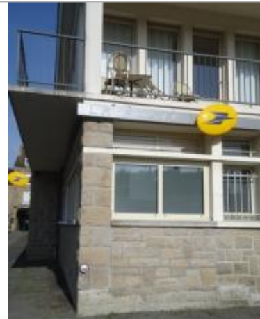
Angle du bâtiment de la Poste - quai du Duc d'Aiguillon
