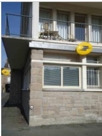
Repère posé en avril 2018 - Source : SMAP
