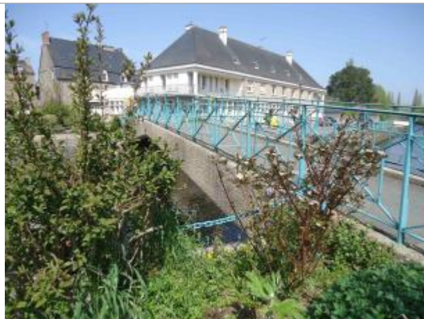
Passerelle piétonne - Source : SMAP, 2018
