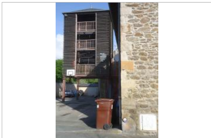
Repère posé en avril 2018 - Source : SMAP
