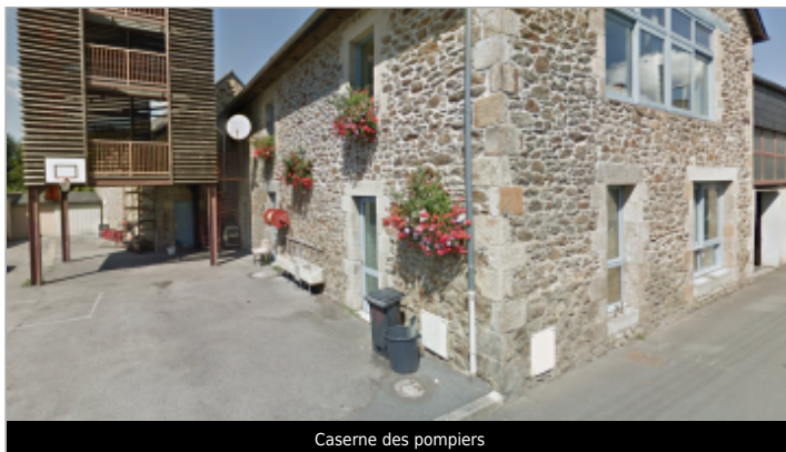
Caserne des pompiers
