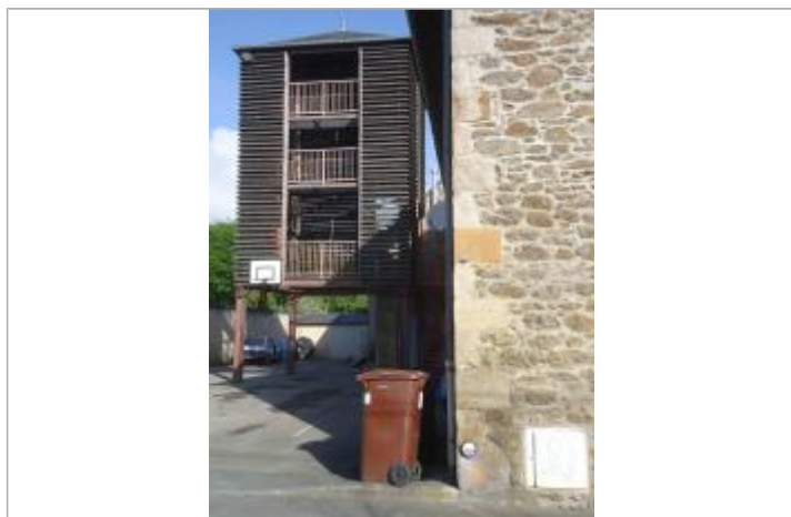
Repère posé en avril 2018 - Source : SMAP
