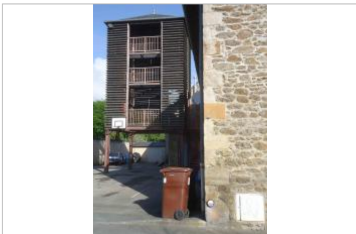
Repère posé en avril 2018 - Source : SMAP
