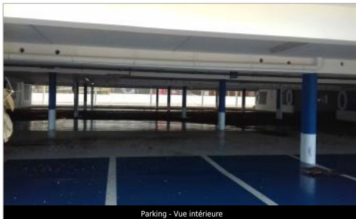
Parking - Vue intérieure
