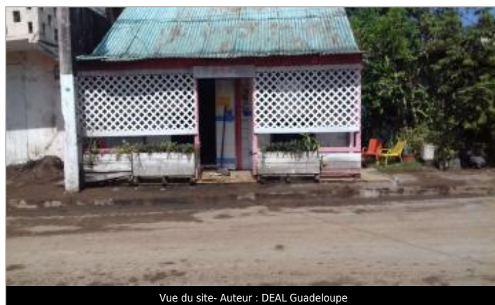
Vue du site- Auteur : DEAL Guadeloupe
