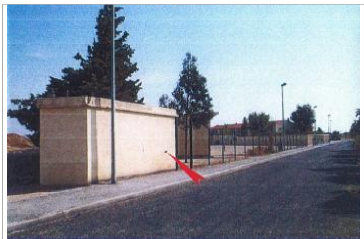
Vue repère sur local avenue du Réart
