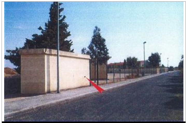
Vue repère sur local avenue du Réart
