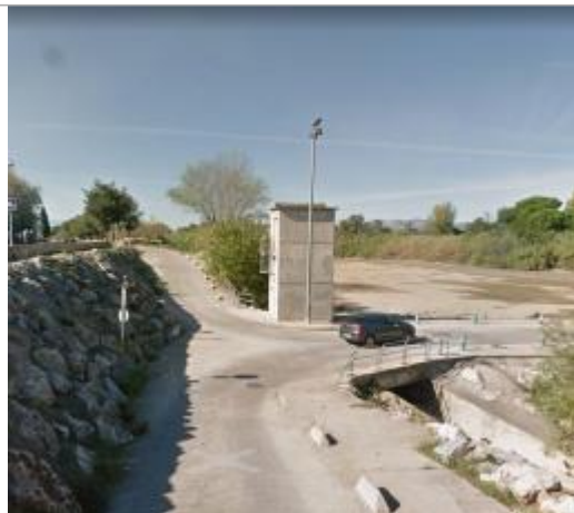
rive gauche poste de relevage à coté du passage à gué
