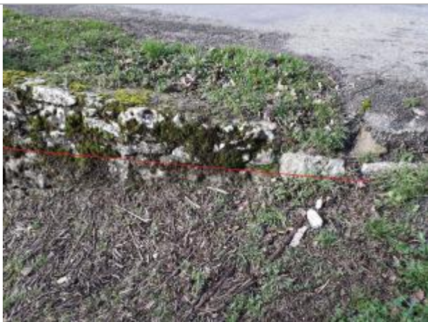
Vue de la laisse - Auteur : Topodoc
