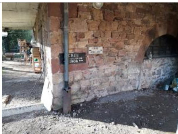
Vue des repères - Auteur : Topodoc
