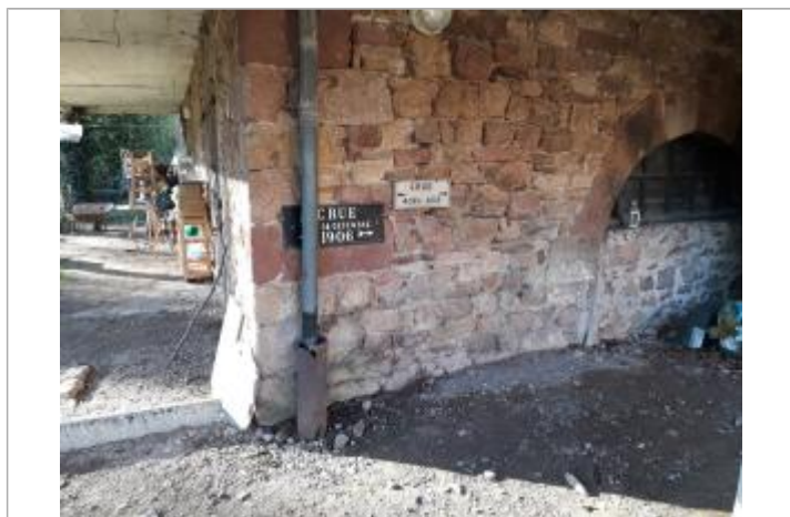
Vue des repères - Auteur : Topodoc
