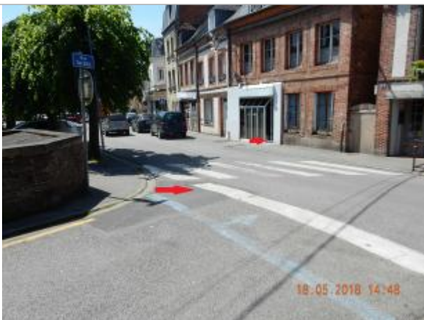
Prise de vue avec la bande blanche d'intersection et le seuil de la porte (Photo : SPC SACN)
